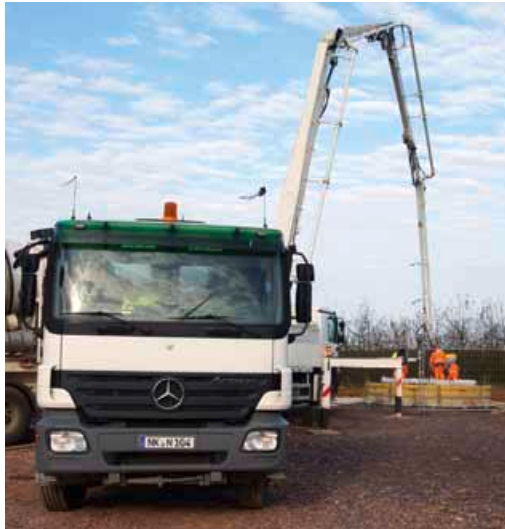
Merchingen II: Nach dem Wege- und Stellflächenbau sowie dem Aushub der Fundamentgrube folgt der dritte Schritt: die Einbringung einer Sauberkeitsschicht und die Armierung
