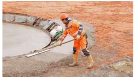
Merchingen II: Nach dem Wege- und Stellflächenbau sowie dem Aushub der Fundamentgrube folgt der dritte Schritt: die Einbringung einer Sauberkeitsschicht und die Armierung
